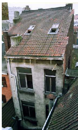
Kaasmarkt – blok 12 - Leegstaande verdiepingen; gebrek aan onderhoud van de gevels
