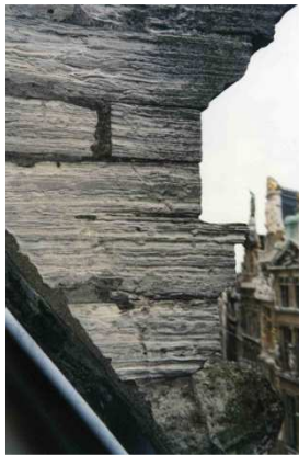
Verschillende vormen van aantasting en afschilfering van stenen.
