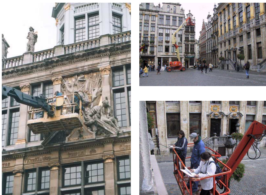
Gevelinspecties vanaf een hoogwerken.
