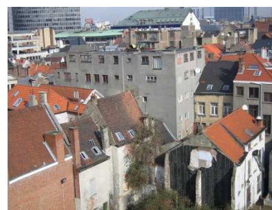
Dichtbouwen van blok 6
