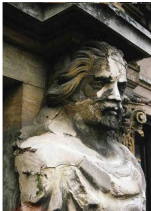
Verschillende vormen van aantasting en afschilfering van stenen.
