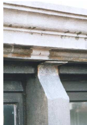
Verschillende vormen van aantasting en afschilfering van stenen.
