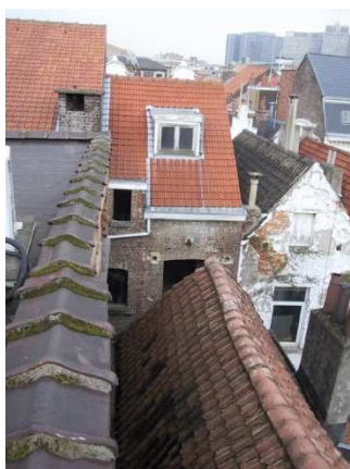
Kaasmarkt – blok 12 - Leegstaande verdiepingen; gebrek aan onderhoud van de gevels
